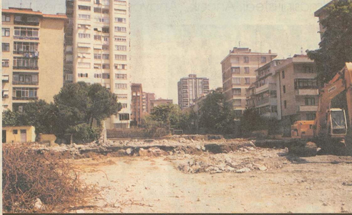
Mahalle'nin simgelerinden Suadiye Lisesi'nin yapımı hızla sürüyor.
